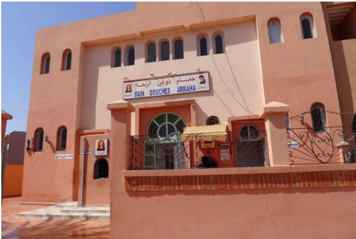
Figure 5.10 Façade, Hammam Douche A-raha, Awatif, Marrakesh
