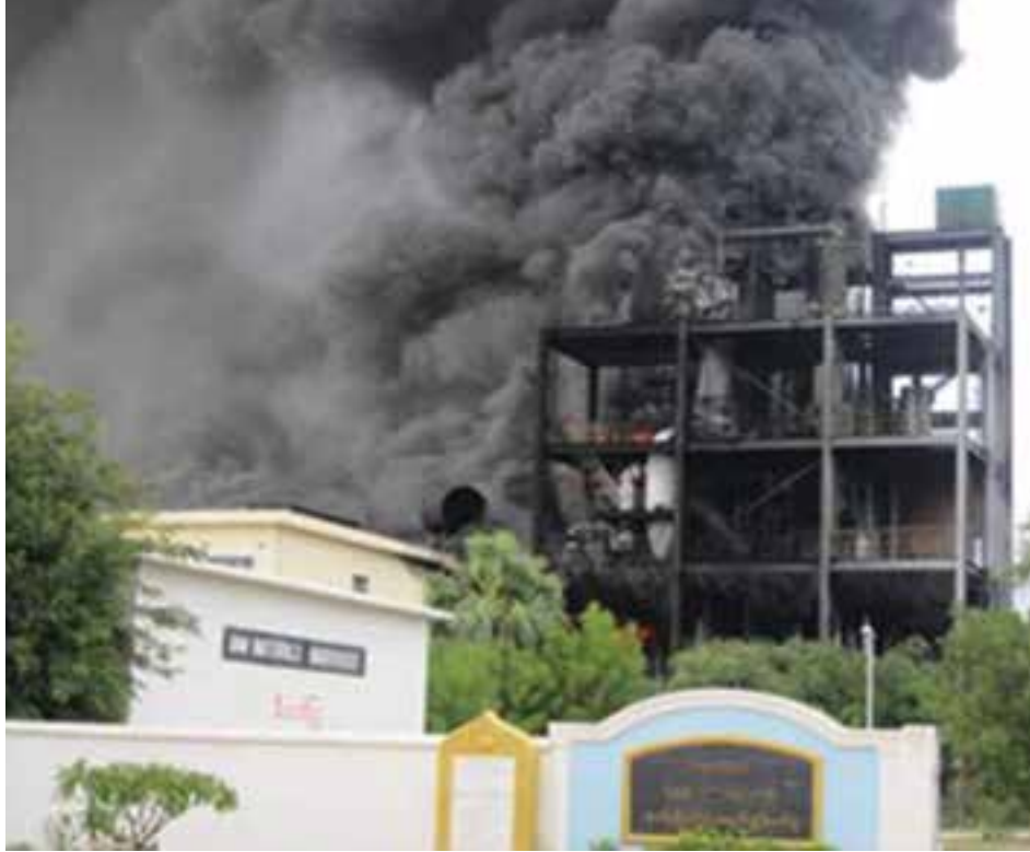
ဟိုက်ဒရိုဂျင်ပါအောက်ဆိုက်စက်ရုံ မီးလောင်ပေါက်ကွဲစဉ်
