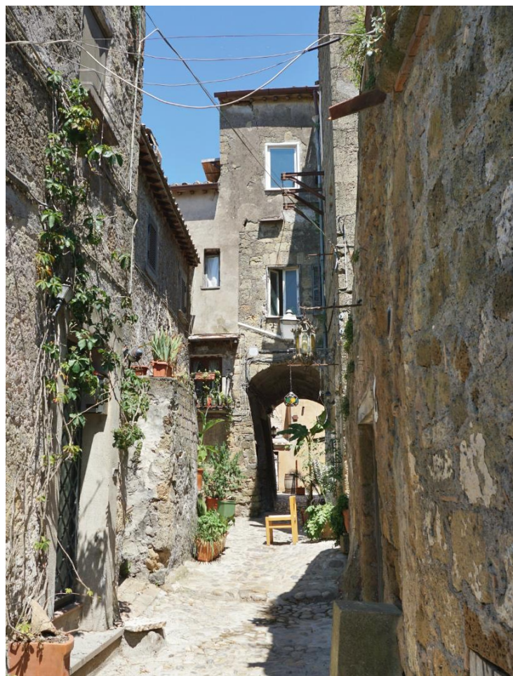
FIGURE 19 Centro storico Calcata
