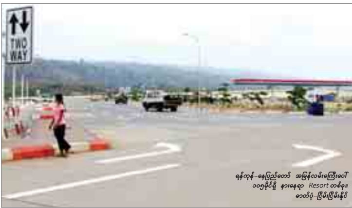
ရန်ကင်း-နေပြည်တော် အမြန်လမ်းမကြီးပေါ် ၁၀၅မိုင်ရှိ နားနေရာ Rest Camp တစ်ခုခု တည်ဆောက်မည့်အတွက် စီစဉ်နေကြောင်း သိရကြောင်း၊ ယာဉ်စည်းကမ်းကော်မတီမှ စစ်ဆေးမှုများ ပြုလုပ်ရန်အတွက် အထောက်အကူပြုရန်အတွက် စီစဉ်နေကြောင်း သိရသည်။
