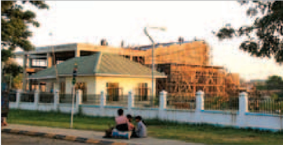
နေပြည်တော်ရှိ ဆောက်လုပ်ဆဲအဆောက်အအုံတစ်ခုနှင့်ဒေသခံကလေးငယ်သုံးဦး
