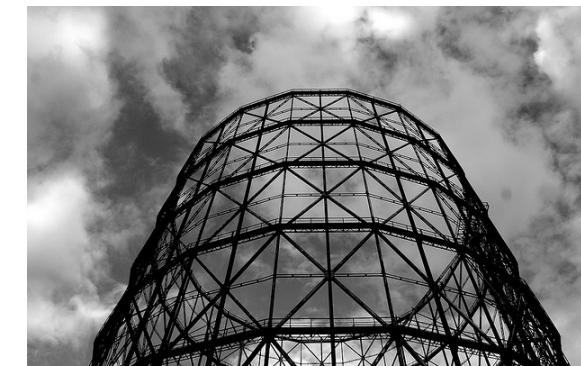
Figure209: Gasometro di Testaccio.
