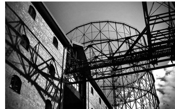
Figure207: Gasometro di Testaccio.
