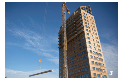
Mjostarnet Tower, Brumunddal, Norway (Voll Arkitekter, 2019)
