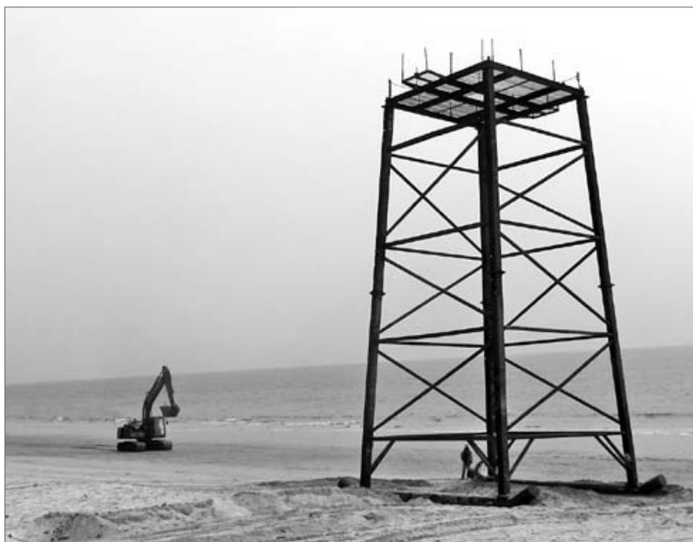
ထားဝယ်ရေနက်ဆိပ်ကမ်း တည်ဆောက်နေမှုကို ၂၀၁၂ ဖေဖော်ဝါရီလကုန်ပိုင်းက တွေ့ရစဉ် ဓာတ်ပုံ-အိမ်ခြံမြေ
