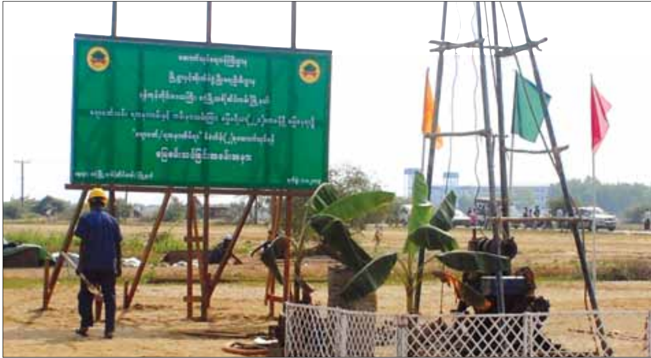
ဒဂုံဆိပ်ကမ်းမြို့နယ်တွင် စတင်တည်ဆောက်လျက်ရှိသည့် ရတနာအိမ်ရာစီမံကိန်းလုပ်ငန်းခွင်
