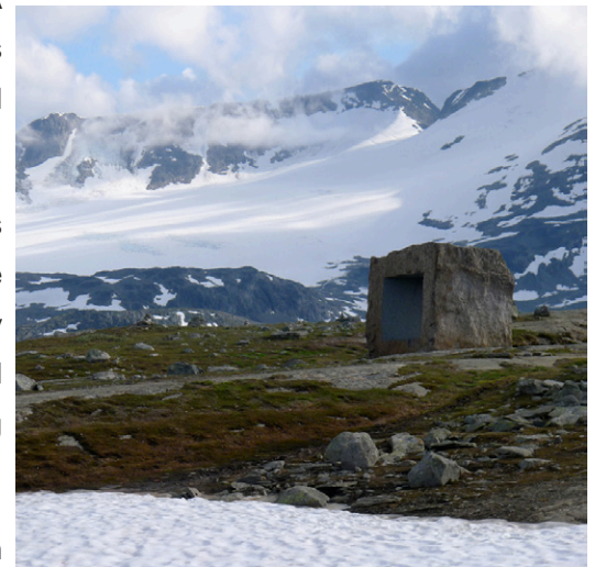
fig. 8 Mefjellet Rest Area, Sognefjellet Road
