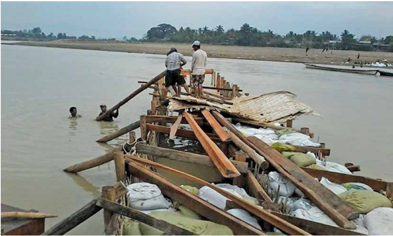
ကိုယ်ထူကိုယ်ထရေကာတာတည်ဆောက်နေစဉ်
