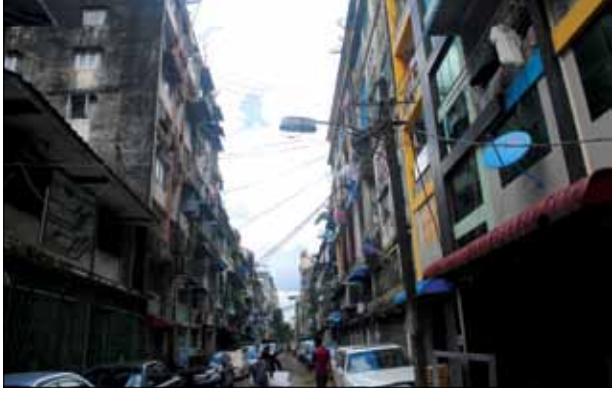
ရန်ကုန်မြို့လယ်ရှိ တိုက်ခန်းများကို ဖြင့်ရစဉ် ဓာတ်ပုံ-ကျော်ဝင်းခန်း
