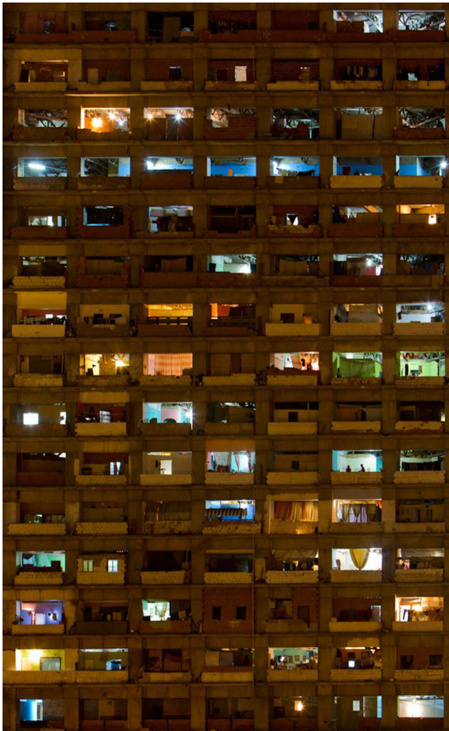
Fig. 69: Torre de David (Centro Financiero Confinanzas) Iwan Baan
