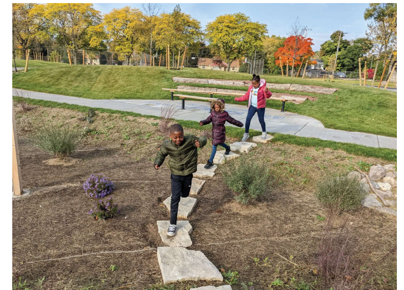
Fig. 4.4: Crossing a bioswale (Reflo)
