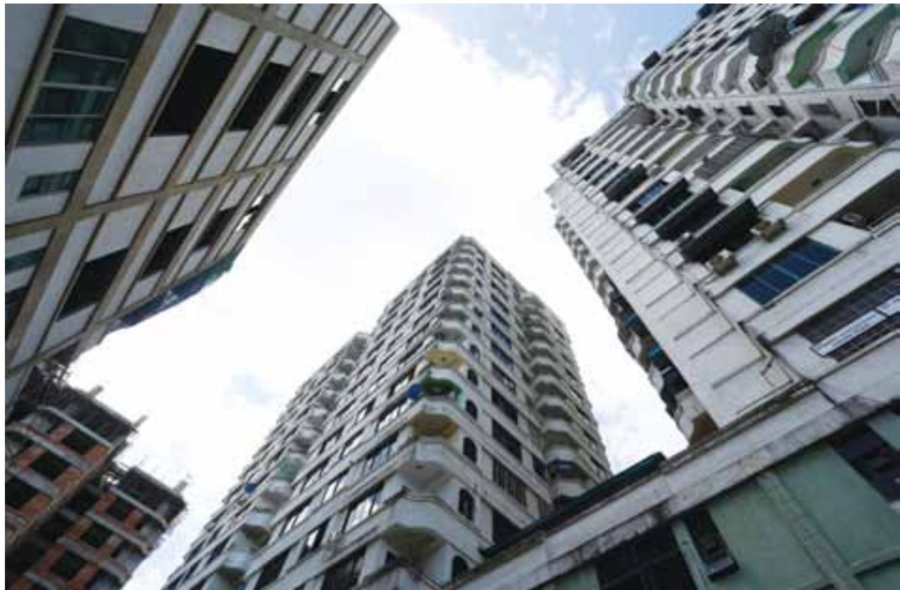
ကမာရွတ်မြို့နယ်အတွင်းမှ တည်ဆောက်ပြီးနှင့်တည်ဆောက်ဆဲ ကွန်ဒိုတိုက်ခန်းတွဲ တစ်တွဲ ဓာတ်ပုံ - ဂျေမောင်မောင်(အမရပူရ)
