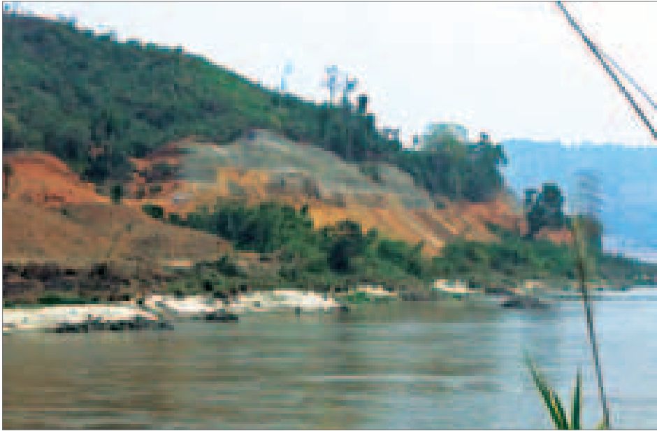
မြစ်ဆုံရေအား လျှပ်စစ်စီမံကိန်းတည်ဆောက်ရေးလုပ်ငန်းခွင်ကို မတ်လကုန်ပိုင်းကတွေ့ရစဉ်။
