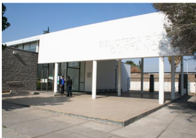
Imagen 49. Fachada Biblioteca Pública Municipal Quinta Normal
