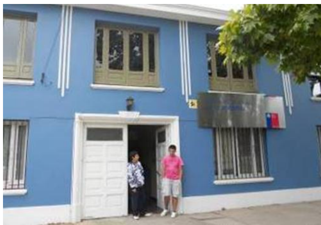
Imagen 23. Fachada Infocentro Sede Regional de INJUV Talca
