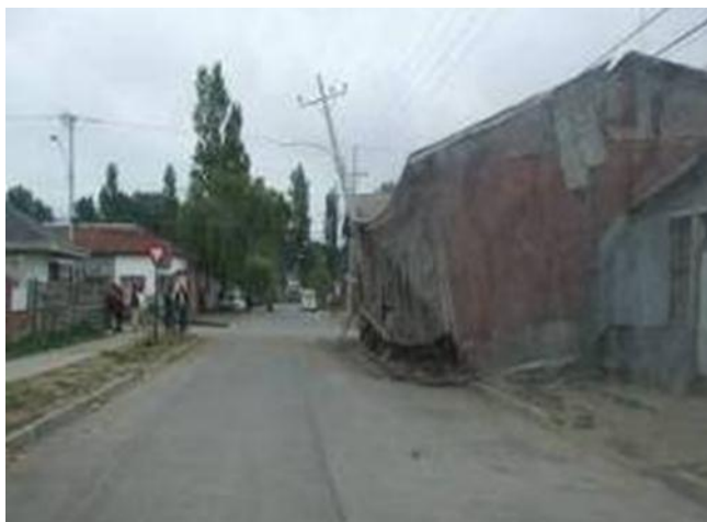
Imagen 31. Calle de Coronel tras el terremoto
