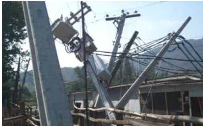
Imagen 3. Daños en postes y redes de cableado eléctrico
