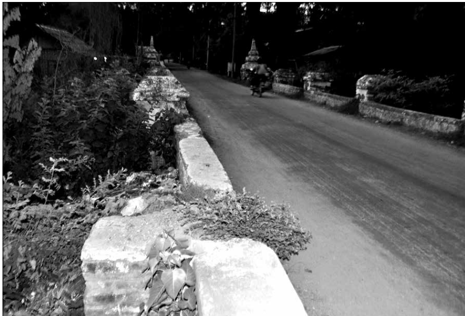
ဇေယျပဋ္ဌတံတားကြီး၏ အပေါ်မှခန့်တစ်ခု တားတိုက်မှုကြောင့်ပြုတ်ကျပျက်စီးနေသည်ကိုတွေ့ ရစဉ်
