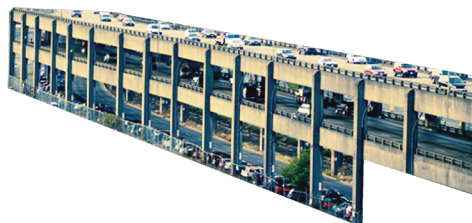
Alaskan Way Viaduct
