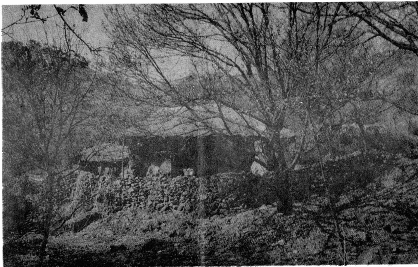
돌담(石牆) : 막돌 허튼총쌓기로 경사지에 낮으막하게 쌓는다. Stone wall built on a slope.
