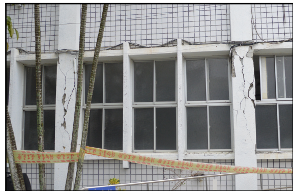
(b) Columns A3 and A4
