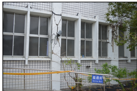
(f) Columns A7 and A8
