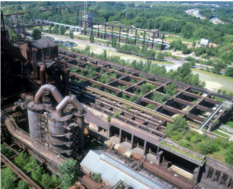
Figure 28. Ore Bunker Gallery (Michael Latz)
