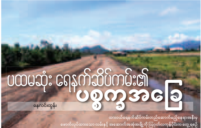
နေလင်းထွန်း ထားဝယ်ရေနက်ဆိပ်ကမ်းတည်ဆောက်မည့်နေရာအနီးမှ ဖောက်လုပ်ထားသော လမ်းနှင့် အဆောက်အအုံအချို့ကို ဩဂုတ်လကုန်ပိုင်းက တွေ့ရစဉ်
