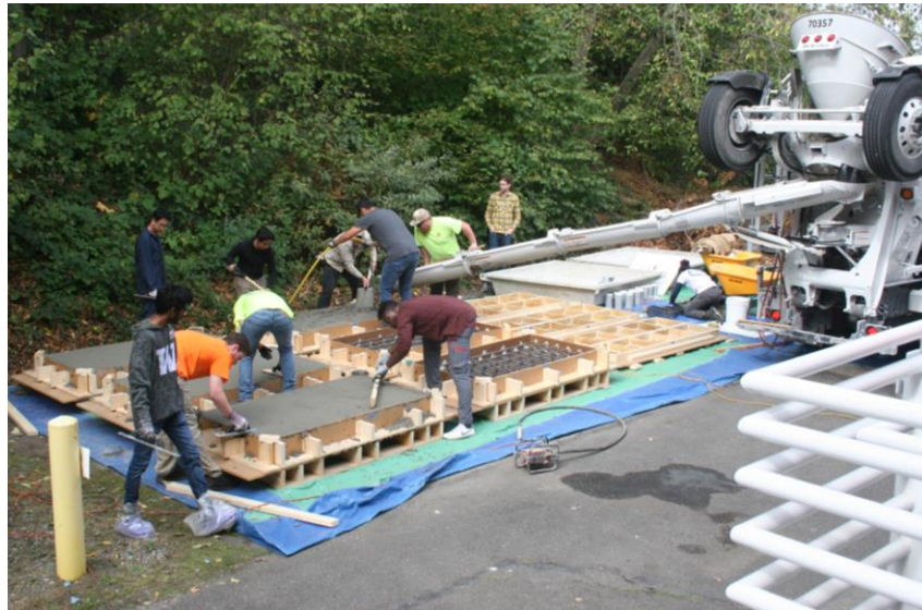
Figure A.10: Concrete Pour in Progress
