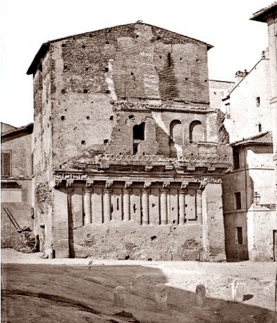
Tower of Niccolò di Crescenzo, or Casa di Cola di Rienzo Corner of Via di Ponte Rotto and Via Petroselli, Rome
