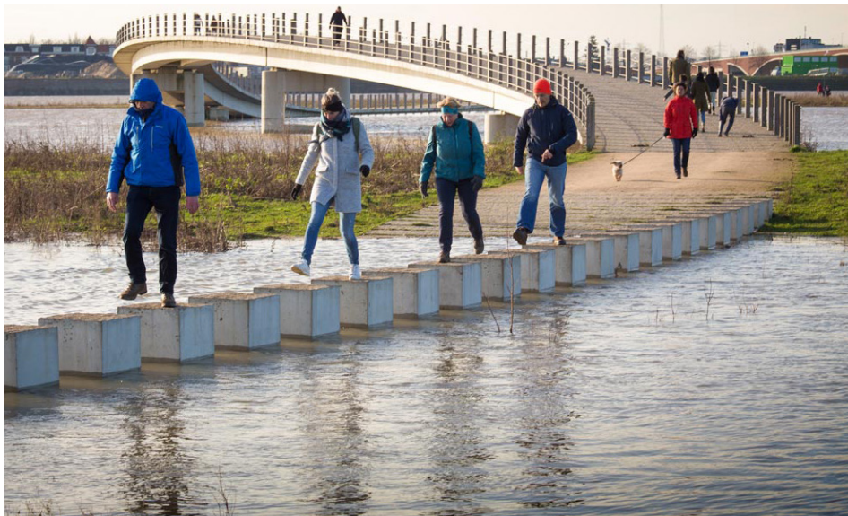
(Figure 9.) (Zalige Bridge, 2016)
