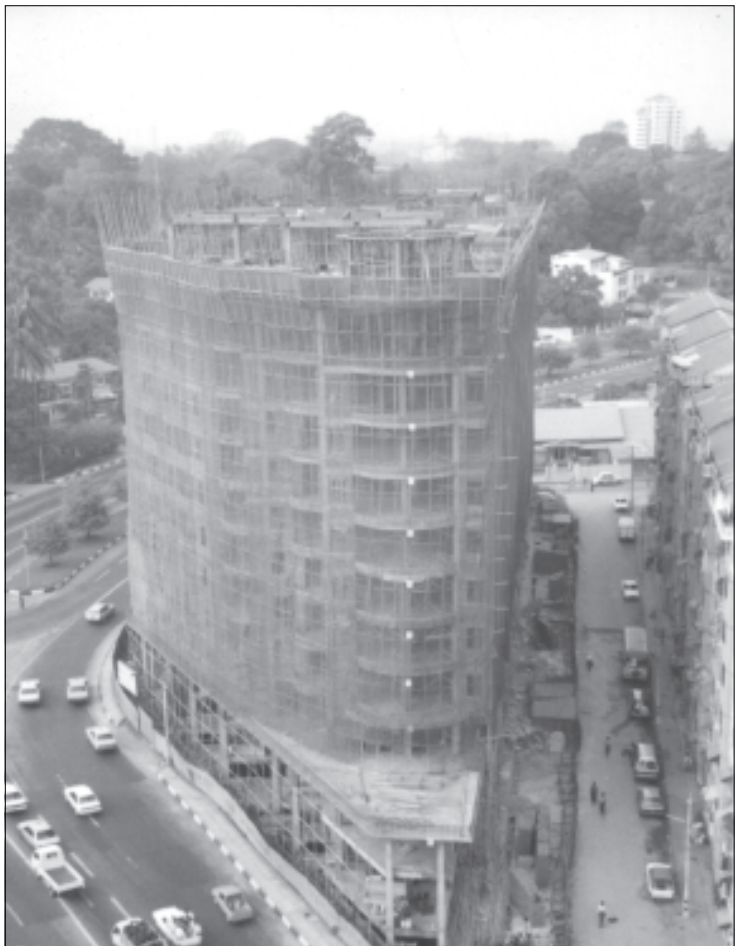
ဗဟန်းမြို့နယ်ရှိ Excel Treasure Tower တည်ဆောက်နေစဉ်
