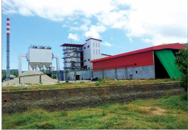
မဂ္ဂါဝပ် ၈၀၀ ဖြန့်ဖြူးမည့် စက်ရုံ တည်ဆောက်ရန်ဖြစ်သည်။ ယင်း
