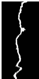
(h) Longitudinal Crack 1
