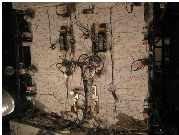
(d) Flange failure (NTW2)
