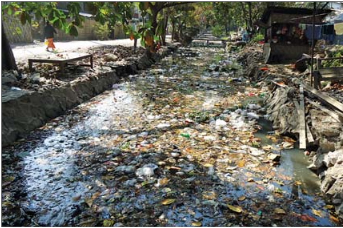
မြောင်းထဲမှရေဆိုးများကိုတွေ့ရစဉ်
