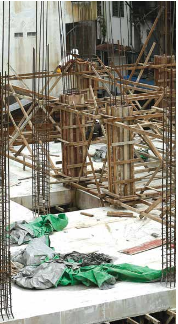
ဓာတ်ပုံ - ဂျေမောင်မောင် (အမရပူရ) ရန်ကုန်မြို့၏ ဆောက်လုပ်ရေးလုပ်ငန်းခွင်တစ်ခုကို တွေ့ရစဉ်
